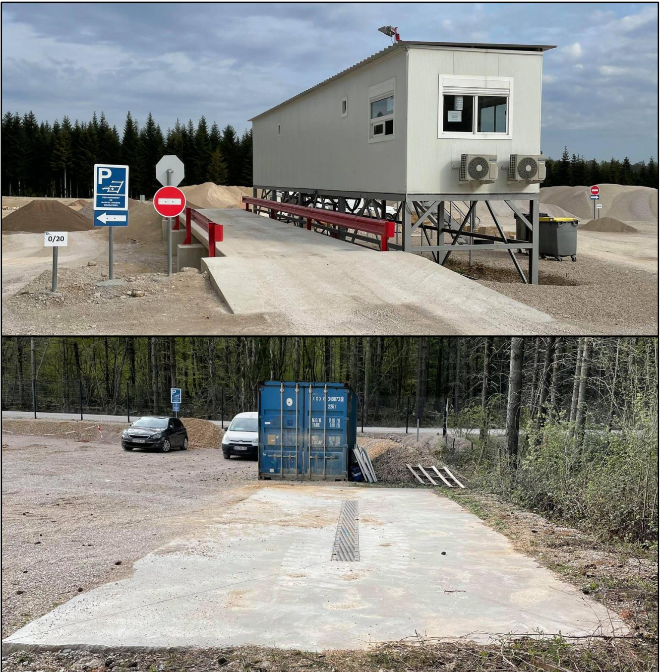
Figure 10 : Photographies du bureau, de la bascule et de l'aire étanche
