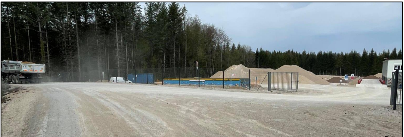
Figure 9 : Photographie de la bascule et du bureau d'accueil depuis l'entrée de la carrière de l'Hôpital-du-Grosbois
